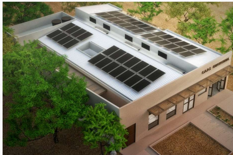
CONSTRUCCION PUESTO DE SALUD GUAYACANAL
